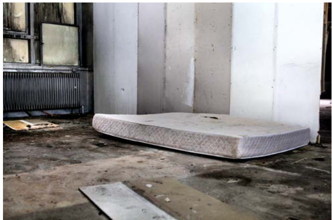
VERLATEN SLAAPPLEK IN EEN AFGEBRANDE BOUWVAL
